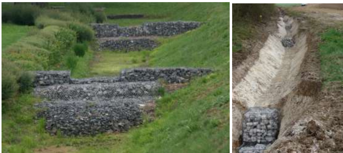
Photo 4 : Fossés à redents en gabions
