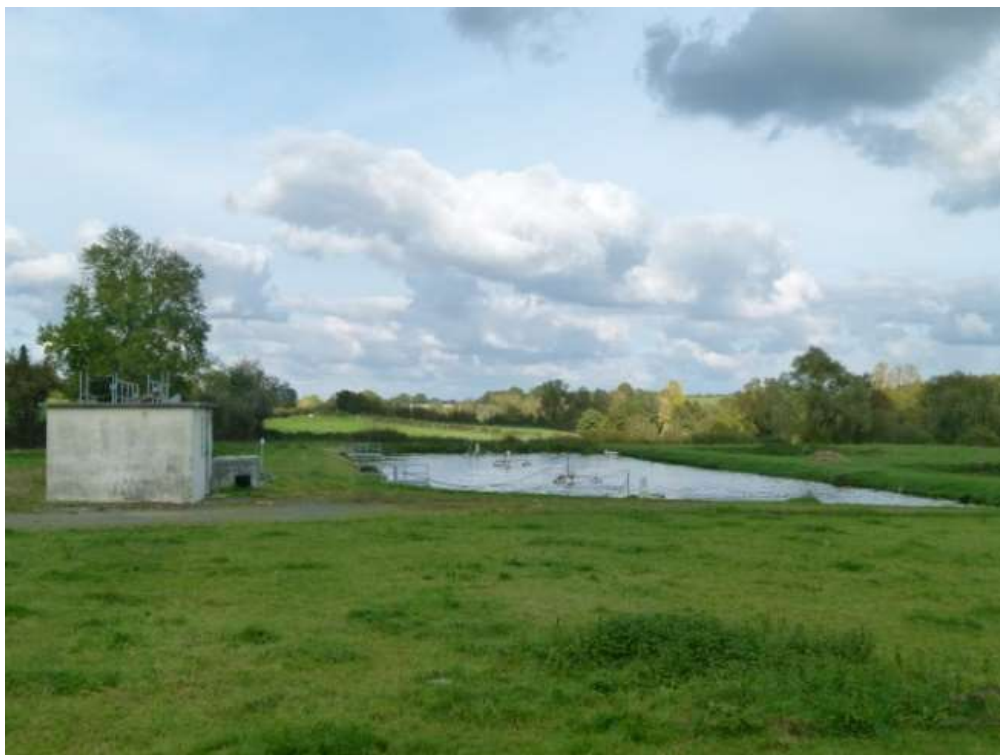
Photo 2 : Station d'épuration du bourg de Neuvy-Saint-Sépulchre
