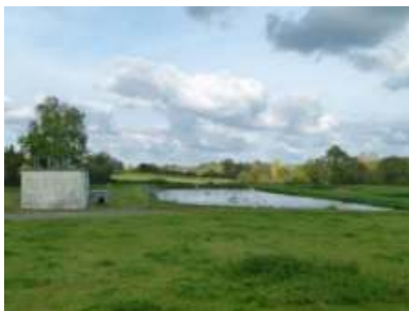
Figure 51 : Station d'épuration du bourg de Neuvy-Saint-Sépulchre » (Source : ADEV Environnement, 2015)
